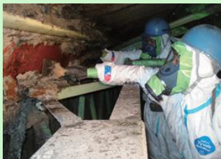
吹付け石綿の除去作業の様子
