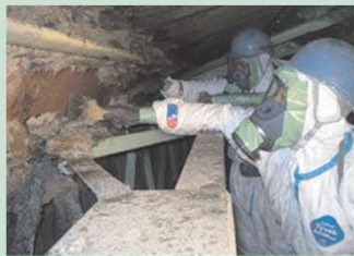
吹付け石綿の除去作業の様子
